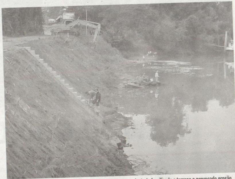
RETIRADA de árvores e da vegetação que cobria o talude, em maio, teria fragilizado o terreno e provocado erosão
