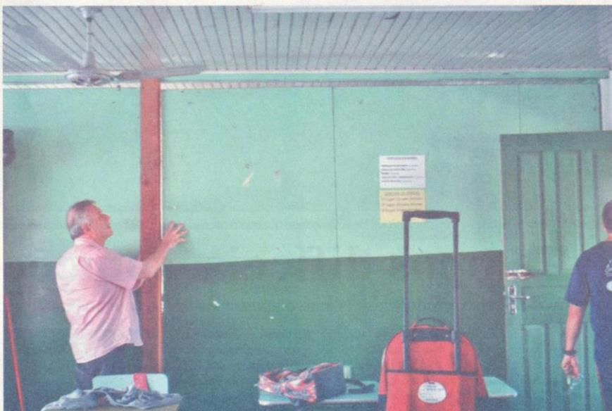
VEREADOR mostra coluna de madeira usada para impedir queda da cobertura. Desabamento é iminente
