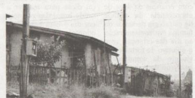
Casa construída no Bairro Bela Vista II
