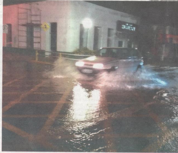
Rompimento de adutora inundou o centro
