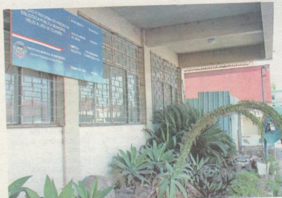
LOCAL foi fechado para realização das obras de reforma da Biblioteca Pública Municipal, que continuam paradas
