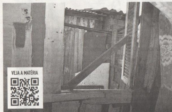
NESTA CASA, a parede de alvenaria simplesmente desabou e foi substituída de forma precária por pedaços de madeira
