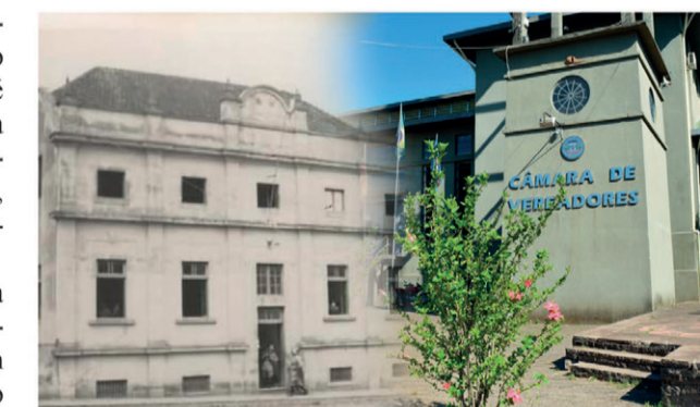
Câmara de Vereadores na Sec. de Obras e na Usina Maurício Cardoso
