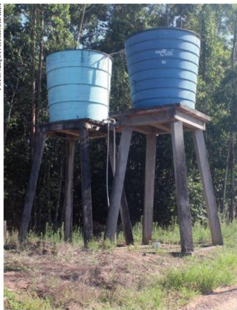
Campo do Meio e Rua Nova serão contempladas
