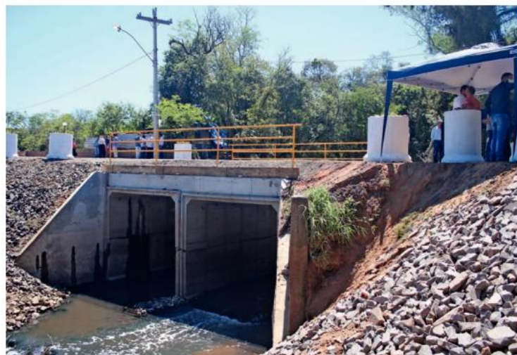
Ponte foi feita com galerias sobre o Arroio Montenegro
