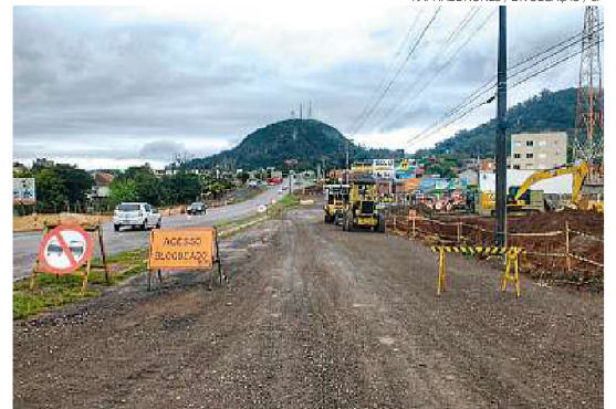
Equipes estão operando máquinas em ambos os sentidos no km 2 da rodovia
