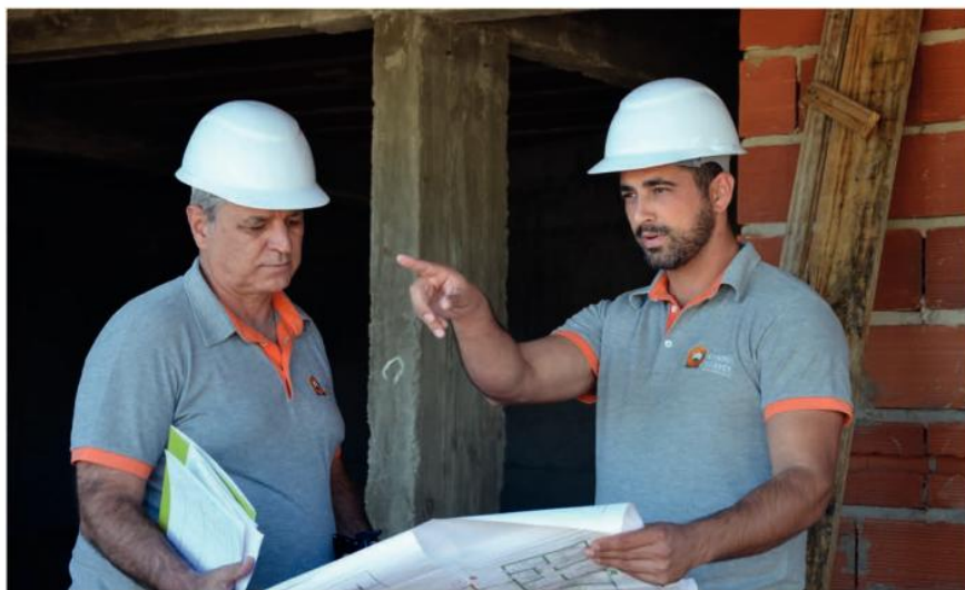
Osvaldo e Felipe, pai e filho, em visita às obras do Residencial São Miguel, localizado no bairro Timbaúva
