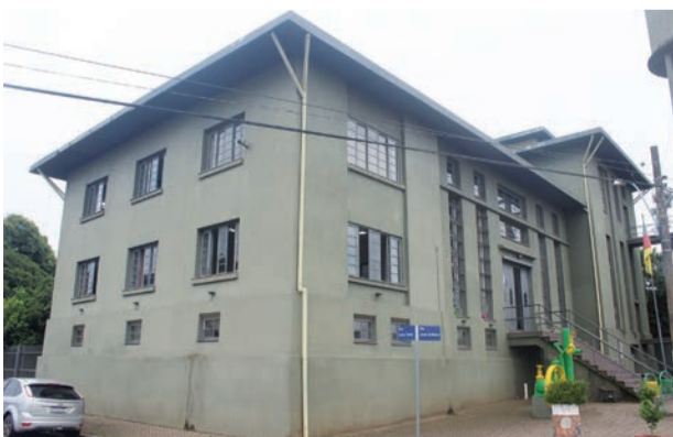
No subsolo, laje em concreto armado e as vigas que a sustentam estão em avançado estado de deterioração
